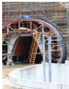
トンネル工事
