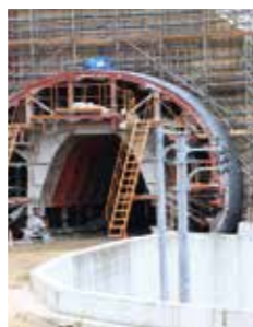
トンネル工事
