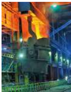
高温、粉塵の多い製鉄所、トンネル工事
