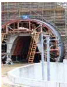
トンネル工事
