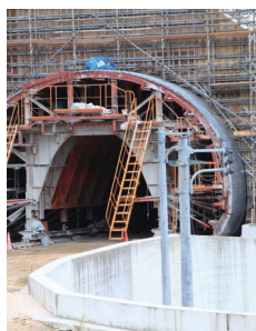
トンネル工事
